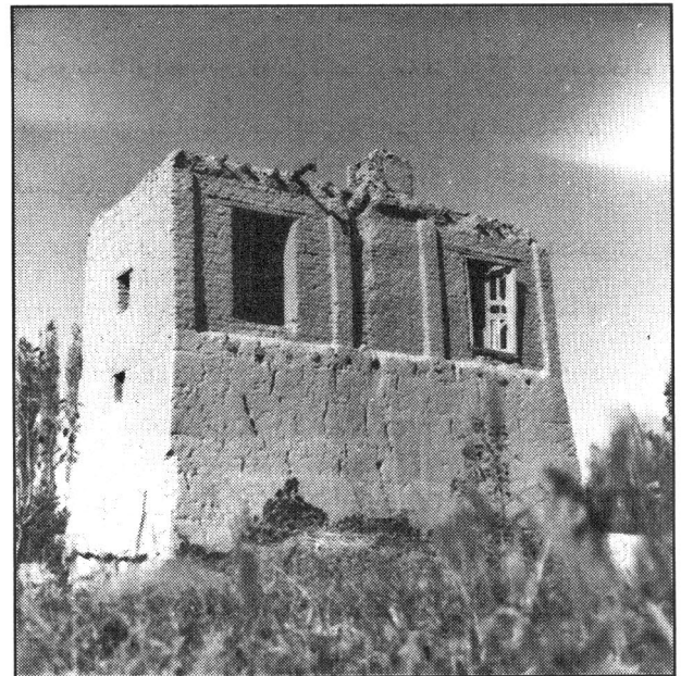
سیدلر چارتاقی (در حال تخریب کامل)
